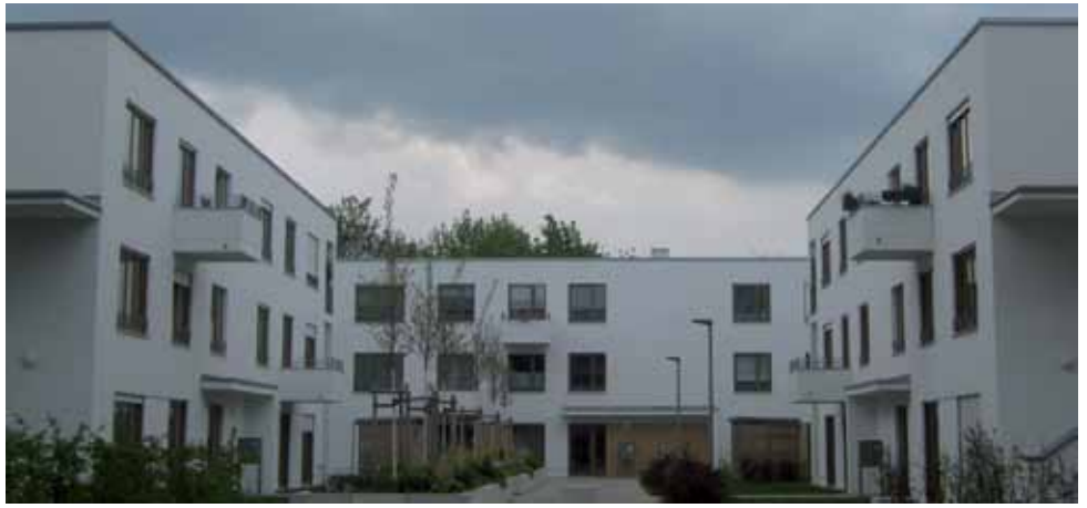
Das neue Wohnviertel „Johannesgärten“ mit über 300 Wohnungen und Tiefgaragen wird bis 2019 fertiggestellt
